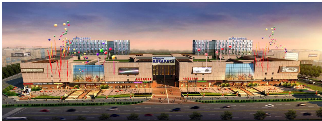
Κτίριο «1» στο WORLD COMMERCE VALLEY
